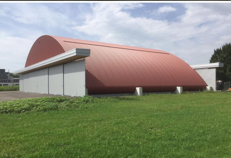
*Der neue Hangar wurde mit Trapezblech verkleidet und ist von beiden Seiten zugänglich.*
